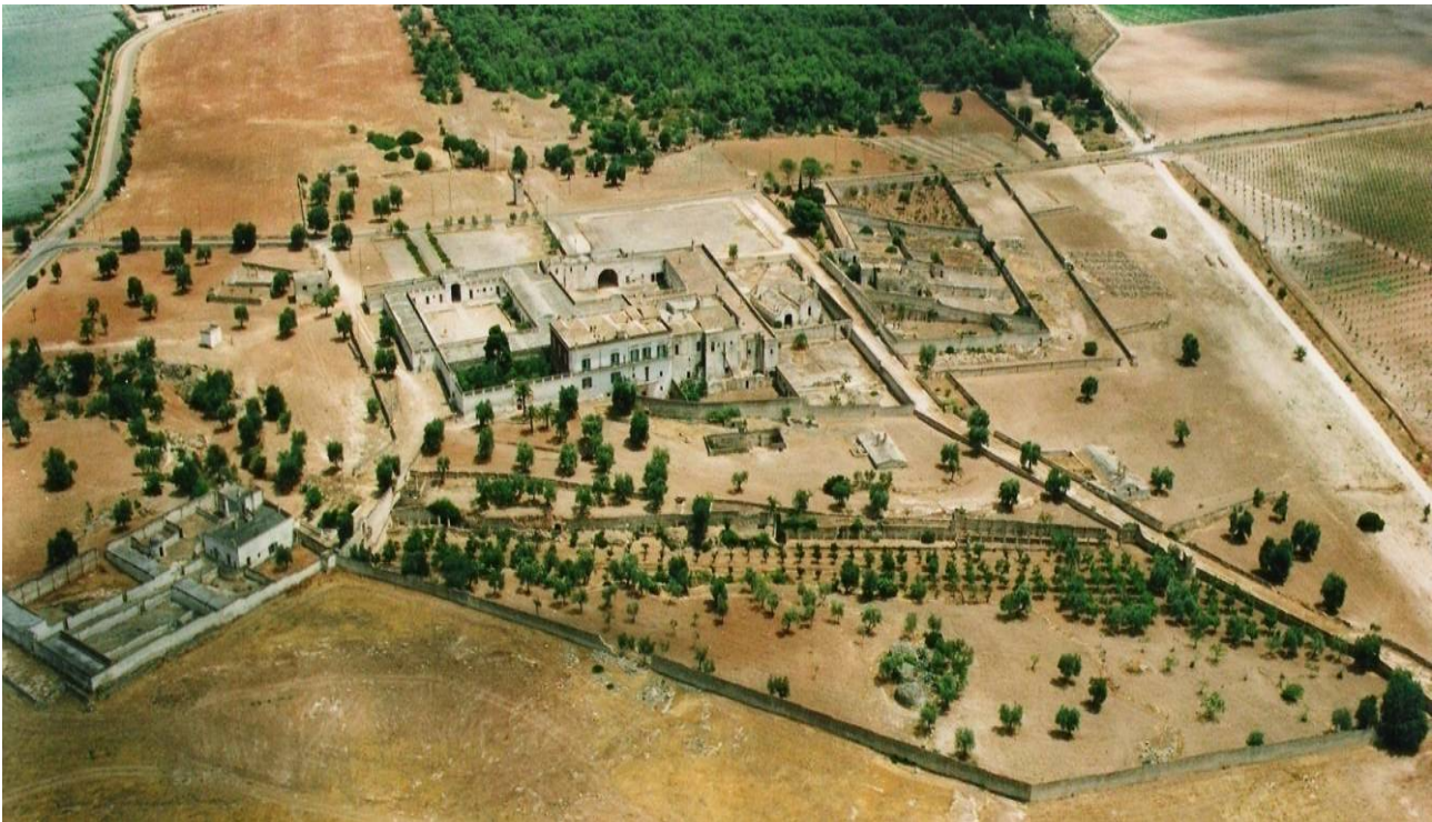
Foto 3 - Vista aerea del complesso della Masseria Accetta Grande – fronte nord ovest
