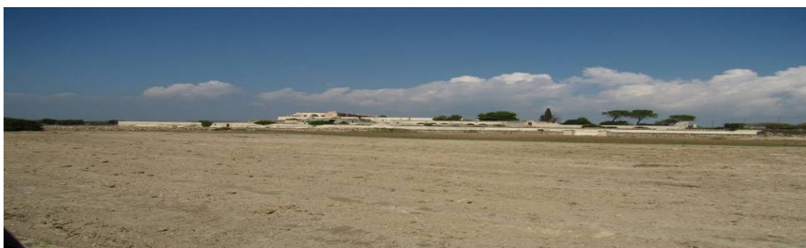
Figura 3.2.1.A - Vista da Sud del Complesso Masseria Accetta Grande
